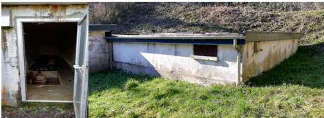
Les bâtiments sont également fortement dégradés. Présence d'humidité sur les murs intérieurs et extérieurs.
